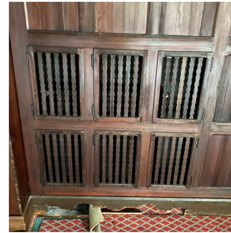
Foto Bestand östliche Wand
